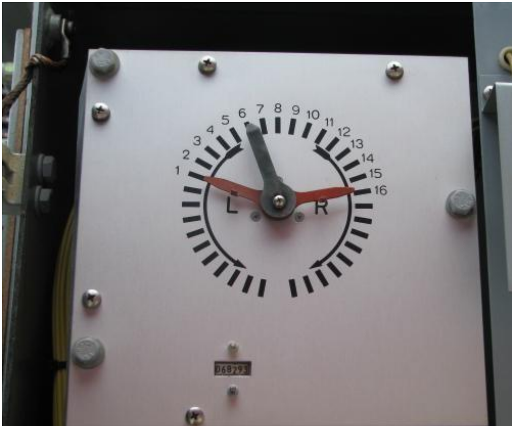
Figura 7. Perilla del cambiador de tomas sin posiciones neutras múltiples
