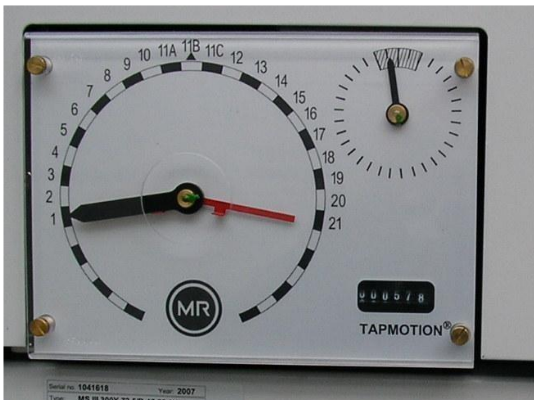
Figura 1. dial MR en un cambiador de derivación
