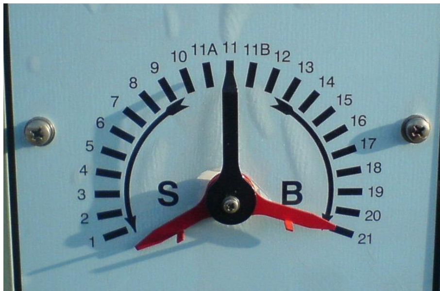
Figura 2. Dial ABB en un cambiador de derivación
