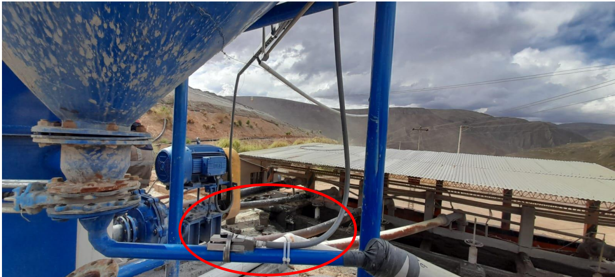
Figura 3. Montaje del transductor de medición en tubería de colas mineras
