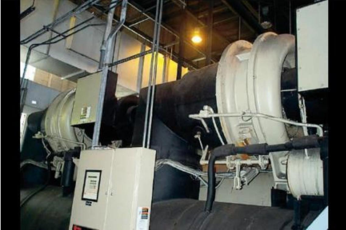
*Frecuentemente, un grupo de enfriadores centrífugos ofrecen capacidad de redundancia y escalonamiento.*
