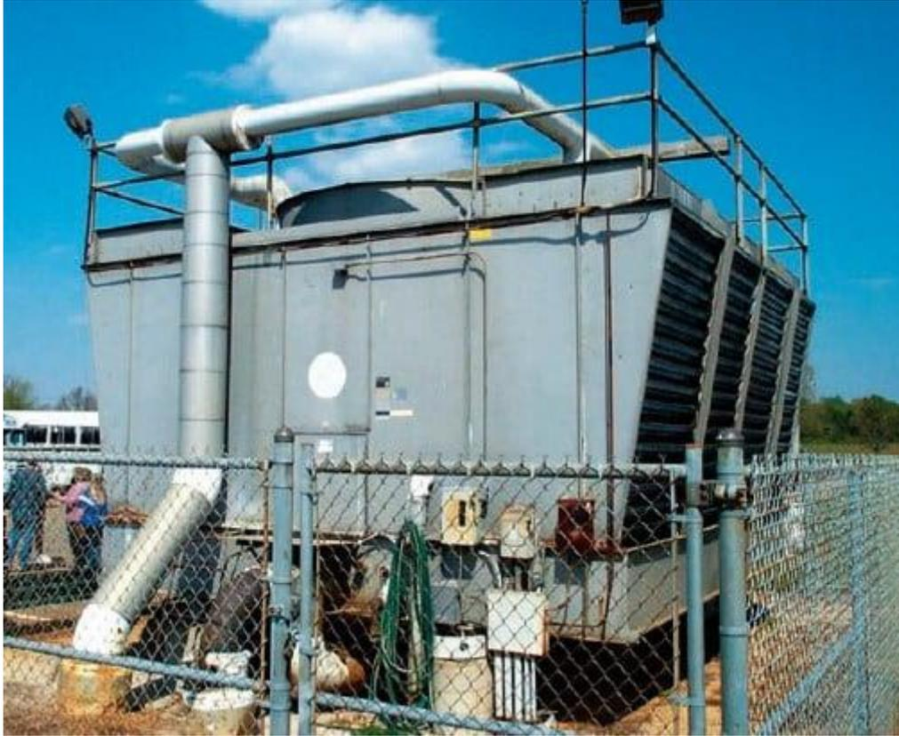
*Se debe probar el aislamiento y los devanados en los motores de ventiladores de torres de enfriamiento.*
