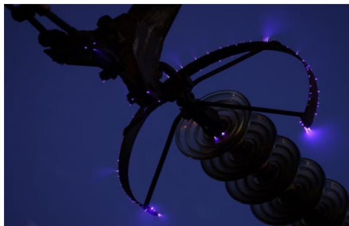
Figura 3: Descarga corona en aislador de línea de 500 kV.
